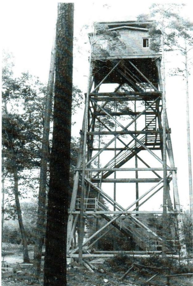
Oben links: Bei Kriegsbeginn errichtete die Zimmerei Loscher / Neuendettelsau in der Muna drei Flaktürme. Die Flugabwehrkanone wurde auf der Plattform oberhalb der Wachstube montiert. Foto: Loscher
