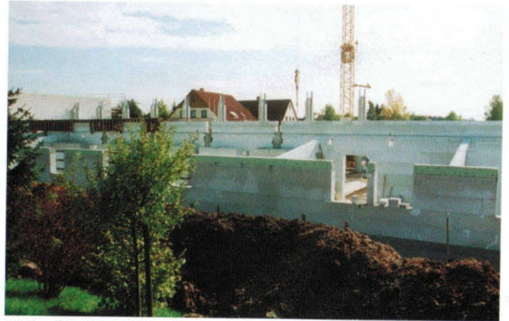
Rückseitig der Fahrzeughalle; Lagerräume entstehen.
