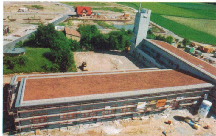
Noch vier Monate bis zur Einweihung; die Innenausbauten laufen auf Hochtouren.
