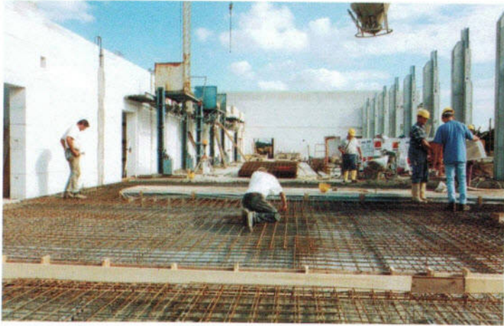
Die Firmen legen sich mächtig ins Zeug, um die Verzögerung aufzuholen. Hier wird die Fahrzeughalle betoniert.
