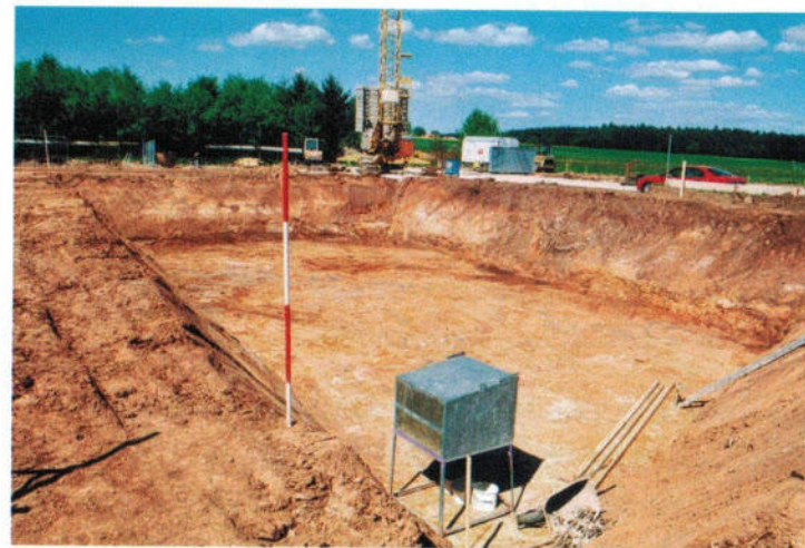
Baugrube für das Hauptgebäude an der Haager Straße
