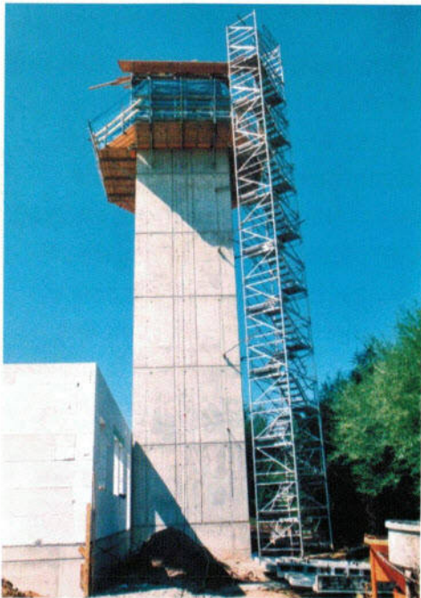
Schlauchtrocken- turm in der Bau- phase.
