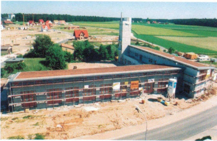
Noch fehlt der Anstrich und der Asphalt vor den Toren.
