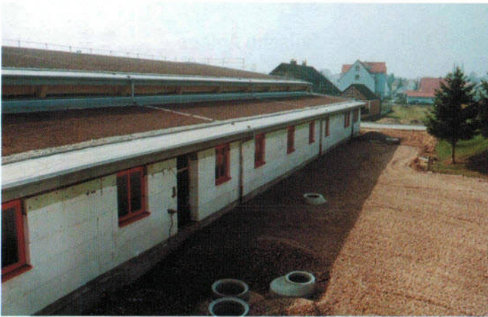
Rückseitiger Hof der Fahrzeughalle.
