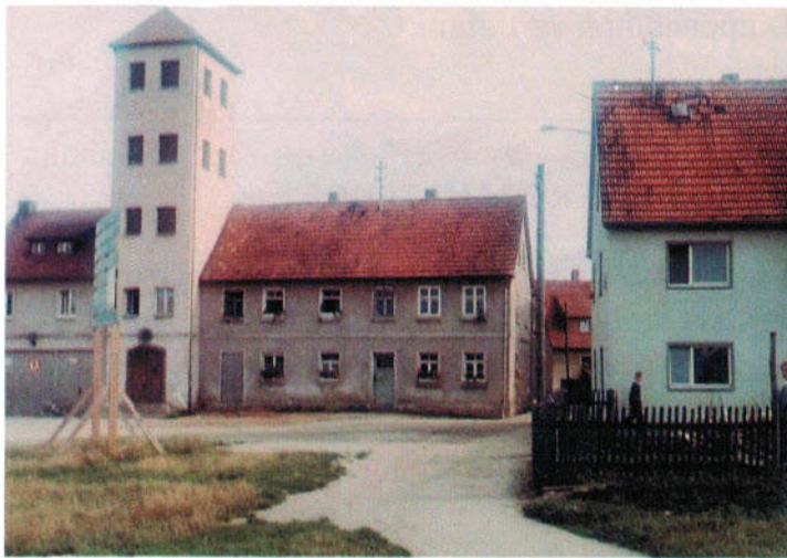
Gerätehaus vor dem 3. Bauabschnitt
