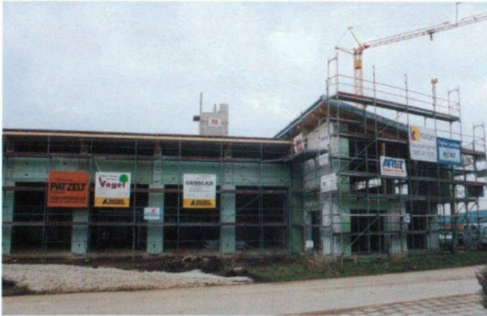
Die Zimmerer fertigen schon die Holzkonstruktion.
