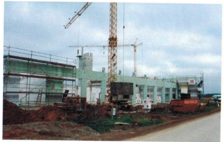
Die Fahrzeughalle nimmt Gestalt an.
