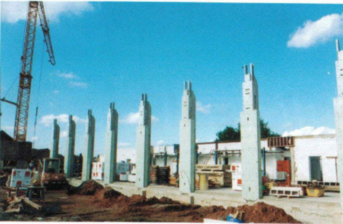
Tragende Konstruktionen an den Hallentoren.
