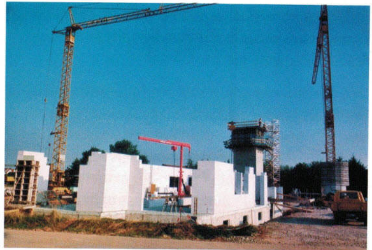
Modernste Baustoffe und Verbindungstechniken kommen zum Einsatz.
