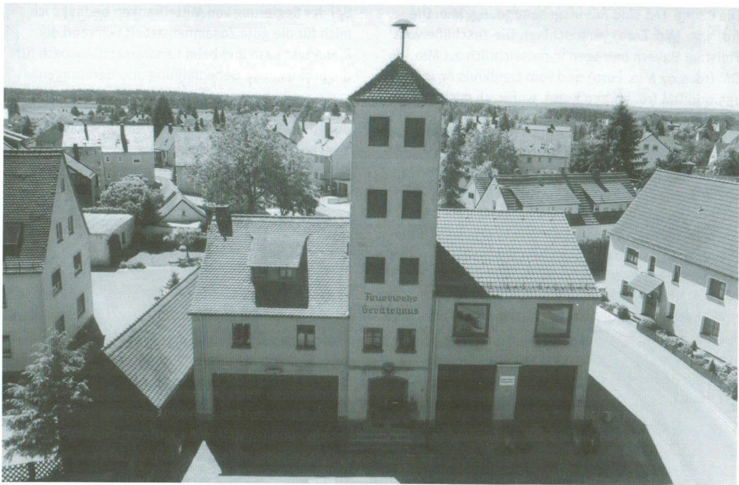
Altes Feuerwehrröhrehaus von 1954 bis 2002.
