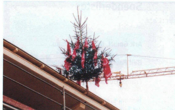
Richtfest am 16. November 2001.
